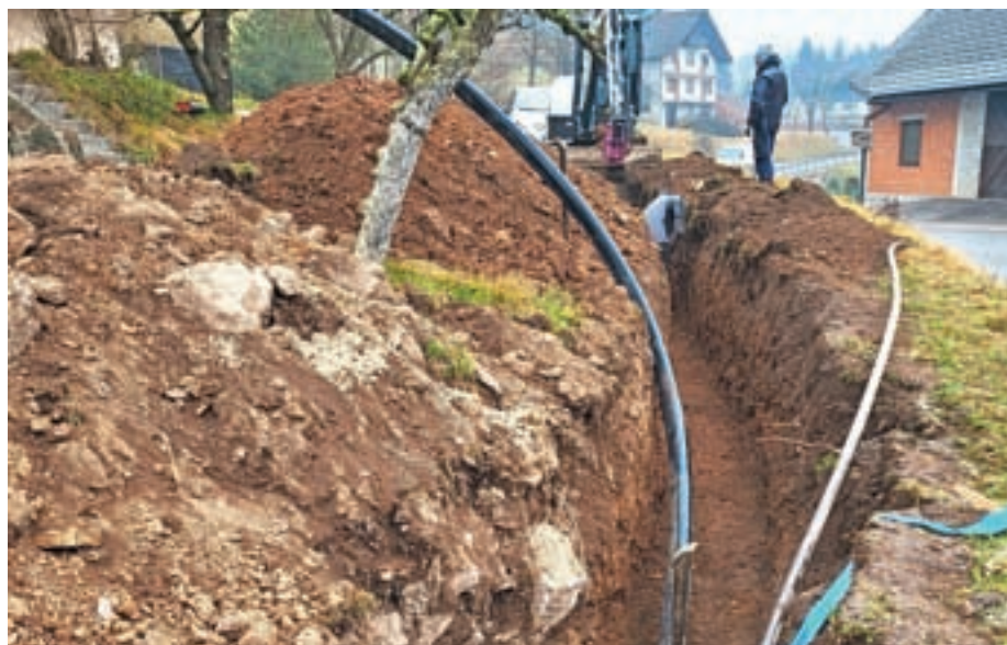
Gradnja vodovoda na Selu Foto: Gašper Kristan
